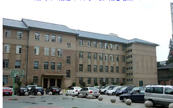
1 科棟＝生体実験が行われていた建物 （当時は3階建てで、その後4階を増築？）
